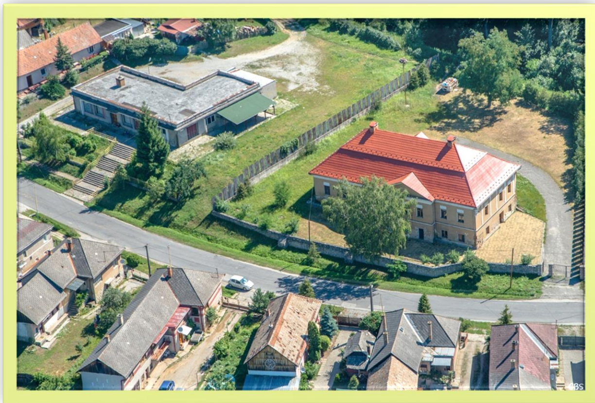
Príloha 1. Pohľad na centrum obce Hucín
